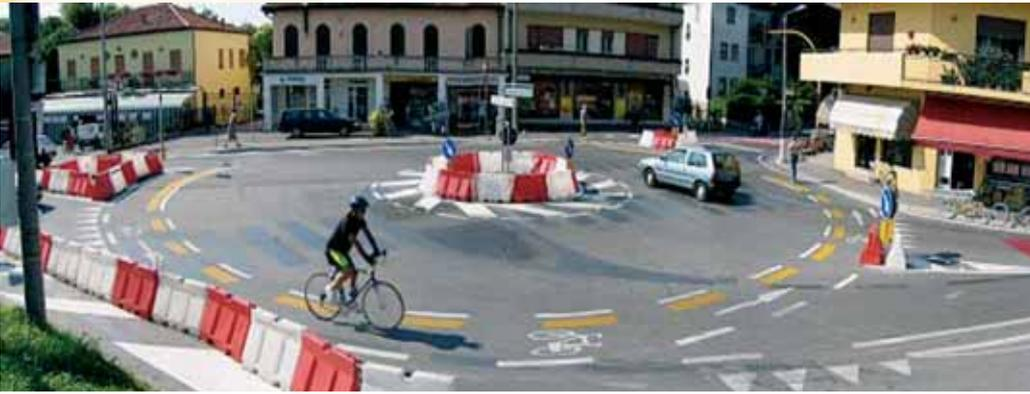
**Figura 9** – Rotatoria compatta con corsia riservata per le biciclette, anche nelle fasi sperimentali o di cantiere.
