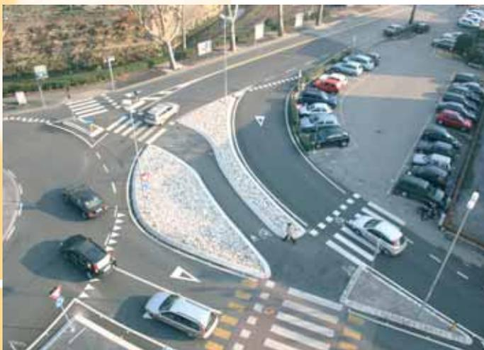
**Figura 12** – Rotatoria grande di 40 m di diametro con percorso ciclopedonale esterno e attraversamenti ciclabili rialzati e attraversamenti ciclabili rialzati e a raso in funzione dei flussi di traffico automobilistico.
