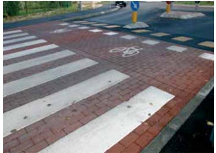
**Figure 14, 15 e 16** – L'attraversamento rialzato va accompagnato da un'opportuna segnaletica che lo rende visibile e riconoscibile anche con il buio. Particolare attenzione deve essere posta all'illuminazione dell'attraversamento.
