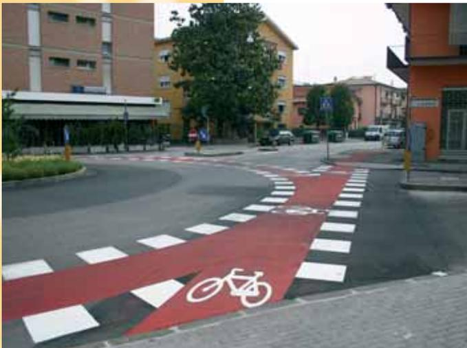
**Figura 10** – Rotatoria compatta con corsia di attraversamento (1 metro di larghezza netta) per ciclisti in anello, ingresso e uscita della rotatoria.
