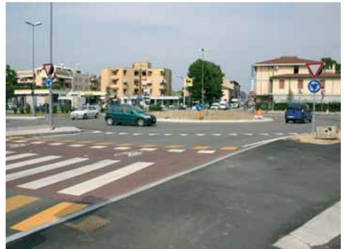
**Figura 11** – Rotatoria compatta di 35 m di diametro con percorso ciclopedonale esterno all’anello di circolazione e attraversamenti ciclopedonali rialzati su tutti i rami stradali. Il ciclista ha la precedenza rispetto al traffico automobilistico.
