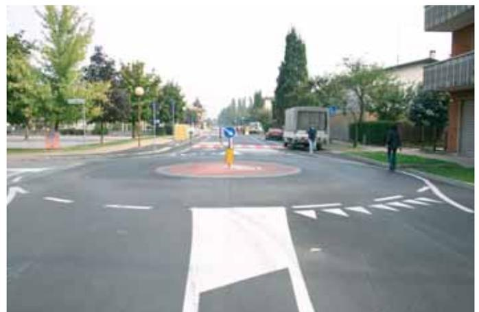
Figure 5 e 6 - Mini-rotatorie con circolazione promiscua delle biciclette.
